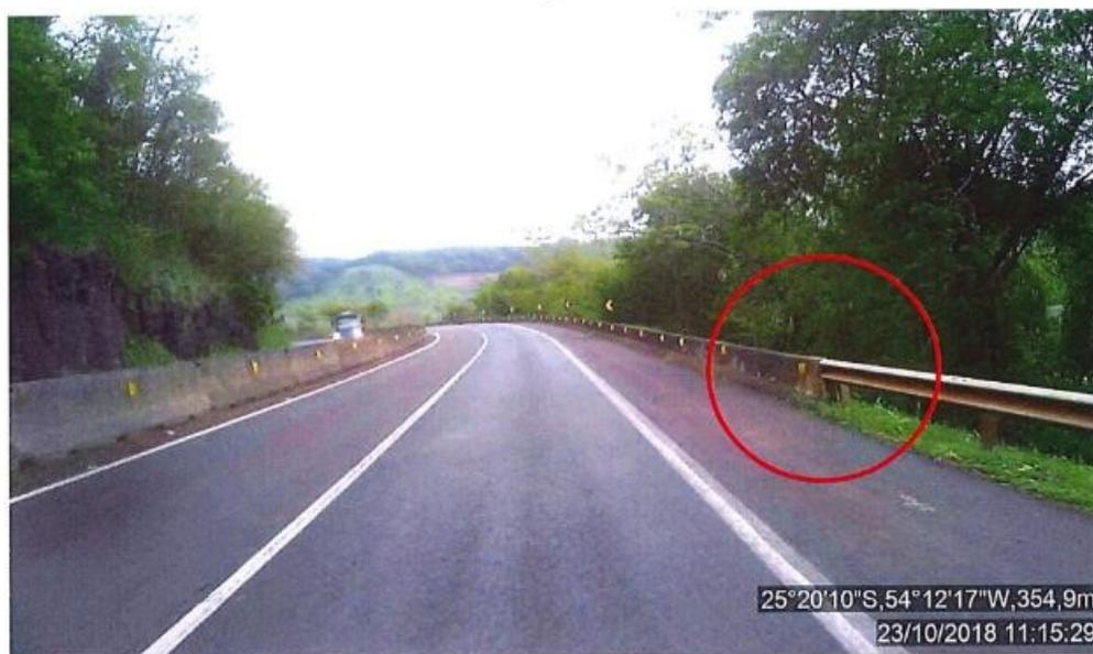
**Figura 12:Transição inadequada entre defesa e elemento rígido: BR-277, Sentido crescente, km 684+620.**
