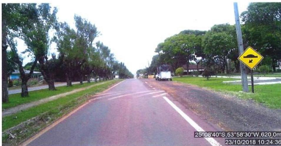
**Figura 45: Sinalização horizontal desgastada (pintura de lombada): PR-590, sentido crescente, km 7+060.**
