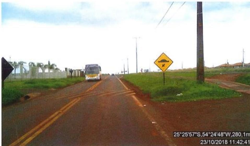
**Figura 50: Sinalização horizontal desgastada e/ou suja (pintura de lombada e linhas de canalização): PR-874, sentido crescente, km 0+780.**
