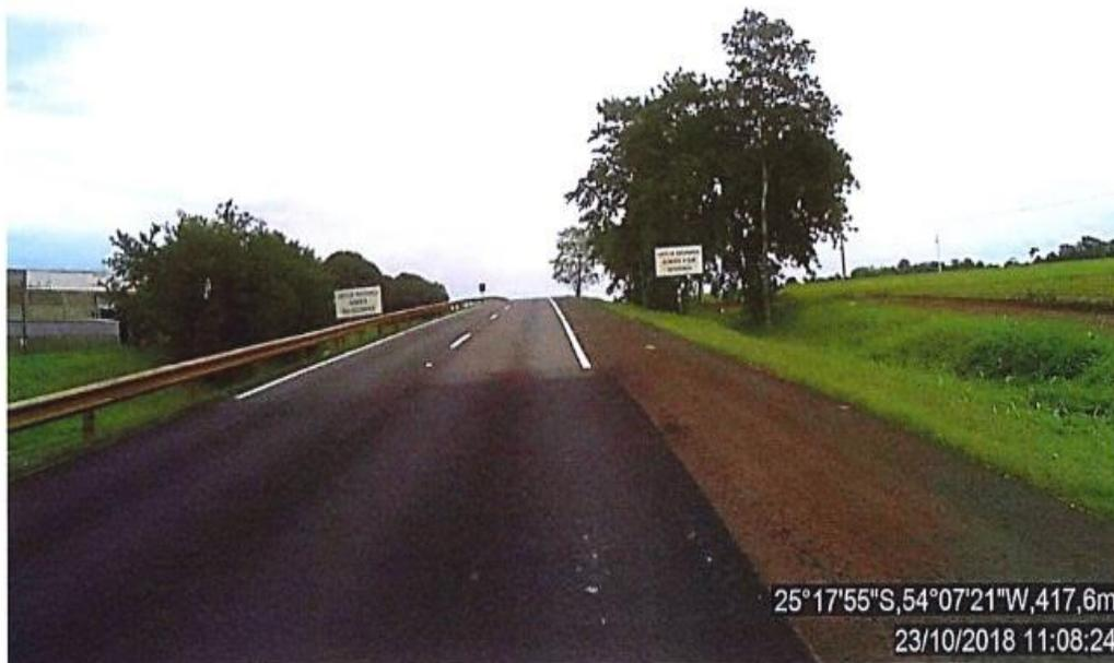
**Figura 33: Não reposição da sinalização horizontal: BR-277, Sentido crescente, do km 674+530 ao km 674+790. Foto no km 674+790.**
