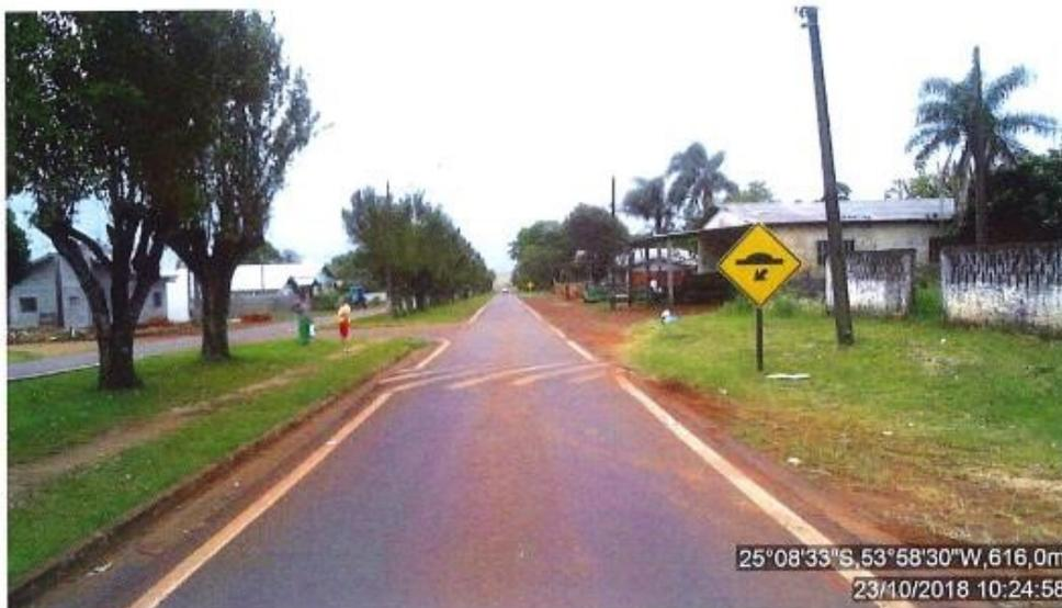
**Figura 47: Sinalização horizontal desgastada (pintura de lombada): PR-590, sentido crescente, km 7+280.**
