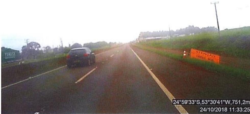
**Figura 38: Placa instalada desnivelada, desuniforme e com a mensagem parcialmente encoberta: BR-277, Sentido decrescente, km 654+630.**
