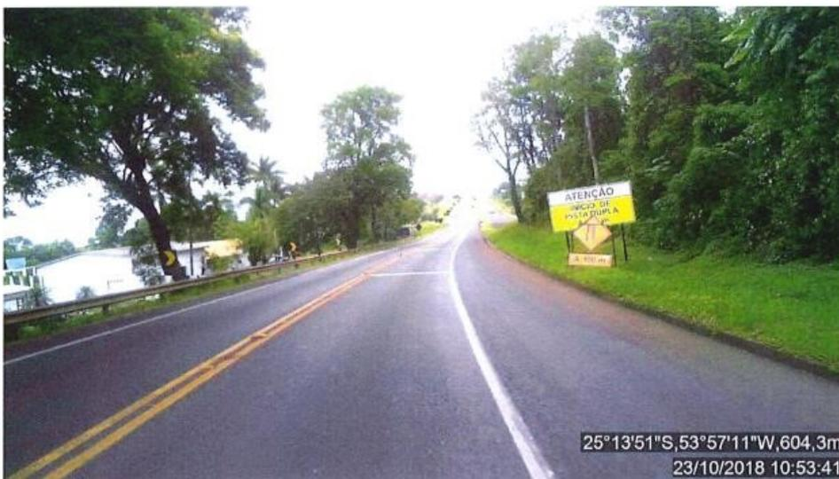
Figura 43: Placa instalada desnivelada, desuniforme e encobrendo sinalização permanente de advertência: BR-277, Sentido crescente, km 655+030.
