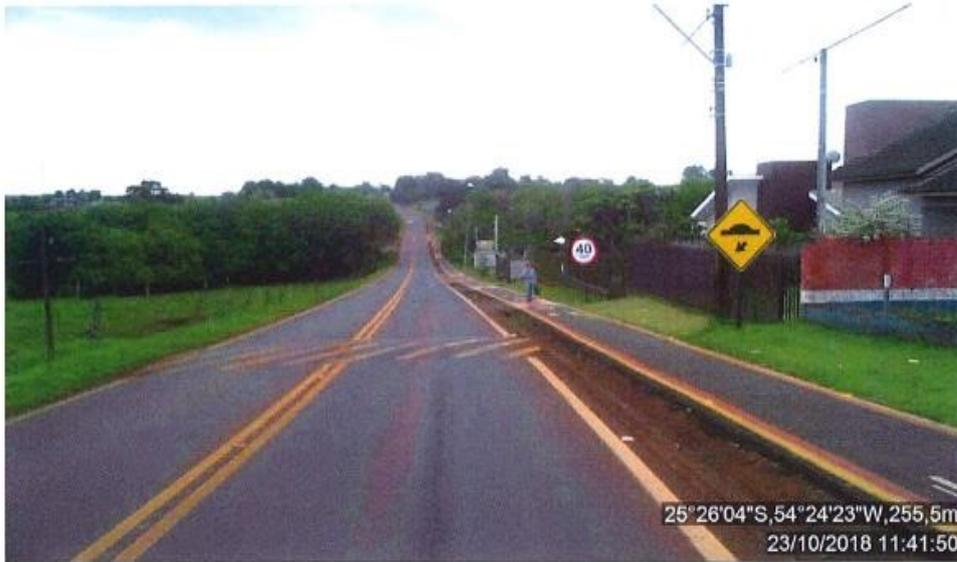
**Figura 49: Sinalização horizontal desgastada (pintura de lombada e linhas de canalização): PR-874, sentido crescente, km 0+030.**
