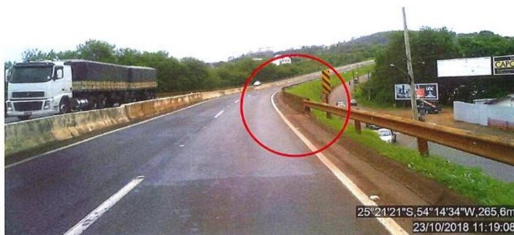
**Figura 16:Transição inadequada entre defesa e elemento rígido: BR-277, Sentido crescente, km 689+510.**
