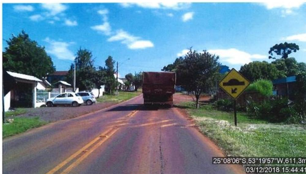
**Figura 56:**Sinalização horizontal desgastada (pintura de lombada): PR-180, sentido crescente, km 355+450.
