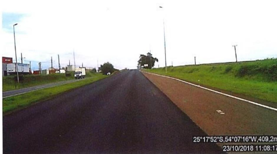
**Figura 32:** Não reposição da sinalização horizontal: BR-277, Sentido crescente, do km 674+530 ao km 674+790. Foto no km 674+650.
