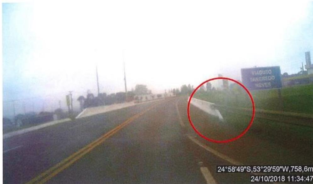
**Figura 11:Transição inadequada entre defesa e elemento rígido: BR-277, Sentido decrescente, km 594+800.**
