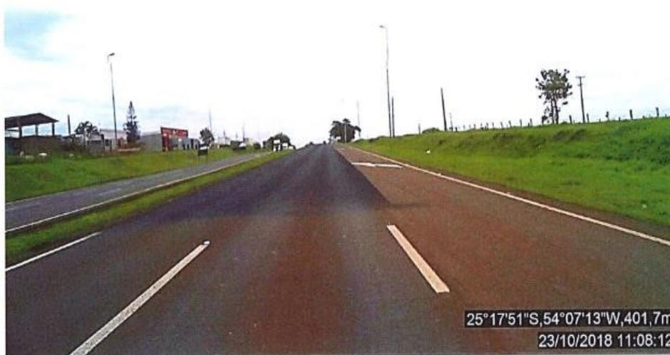
**Figura 31:** Não reposição da sinalização horizontal: BR-277, Sentido crescente, do km 674+530 ao km 674+790. Foto no km 674+530.
