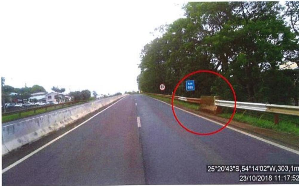
Figura 13: Transição inadequada entre defesa e elemento rígido: BR-277, Sentido crescente, km 687+688.
