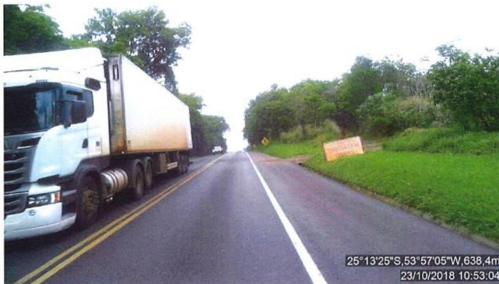
**Figura 40: Placa instalada desnivelada, desuniforme e com a visibilidade comprometida pela vegetação: BR-277, Sentido crescente, km 654+160.**
