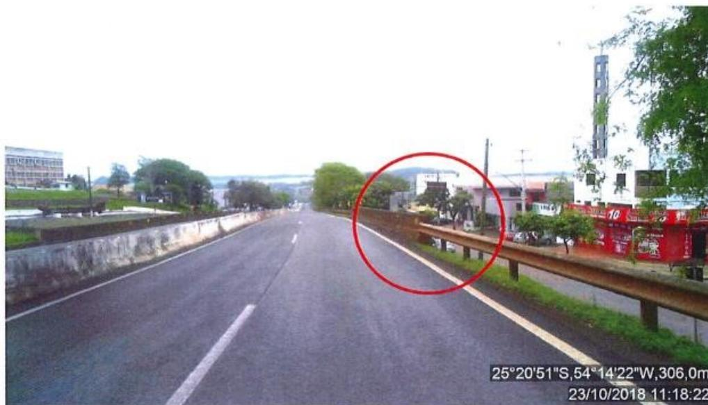
**Figura 15:Transição inadequada entre defesa e elemento rígido: BR-277, Sentido crescente, km 688+530.**
