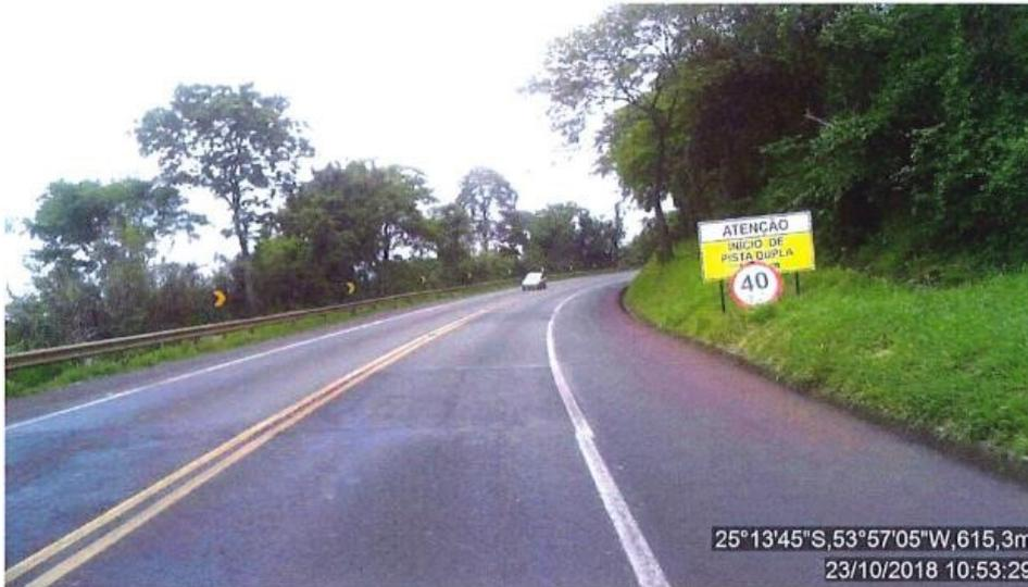
Figura 42: Placa instalada desnivelada, desuniforme e encobrendo sinalização permanente de advertência: BR-277, Sentido crescente, km 654+750.
