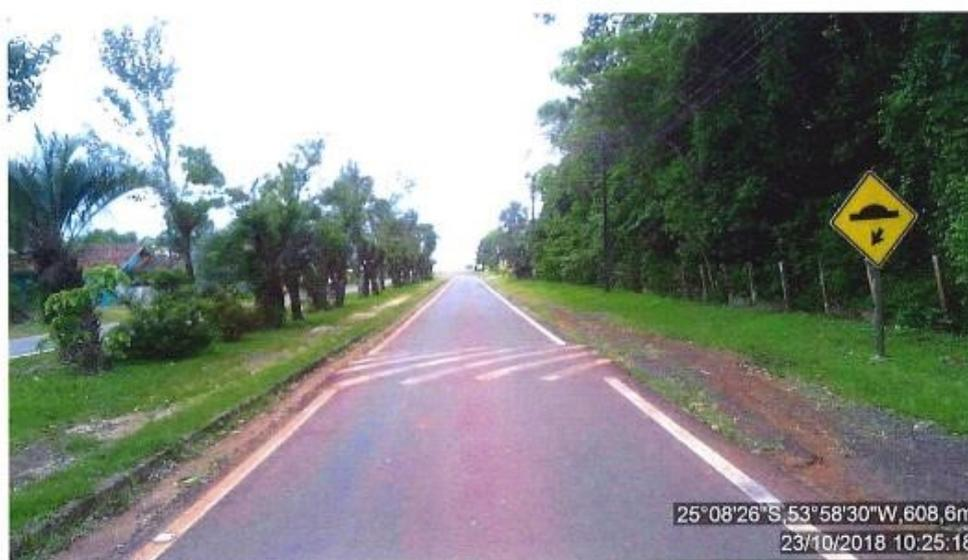
**Figura 48: Sinalização horizontal desgastada (pintura de lombada): PR-590, sentido crescente, km 7+520.**
