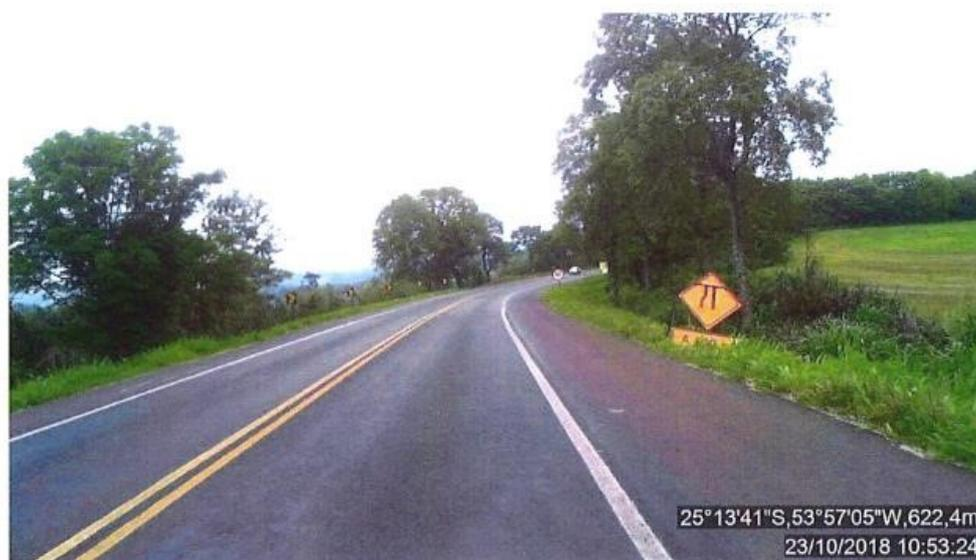
**Figura 41: Placa instalada desnivelada, desuniforme e com a mensagem “A 500 M” encoberta: BR-277, Sentido decrescente, km 654+630.**
