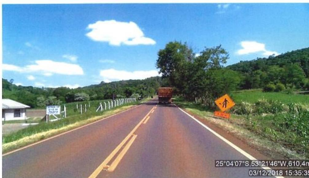
**Figura 60: Placa instalada desnivelada, desuniforme: PR-180, Sentido crescente, km 346+220.**
