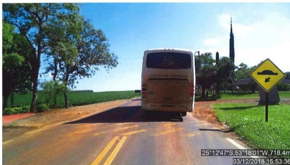
**Figura 58:**Sinalização horizontal desgastada (pintura de lombada): PR-180, sentido crescente, km 365+300.
