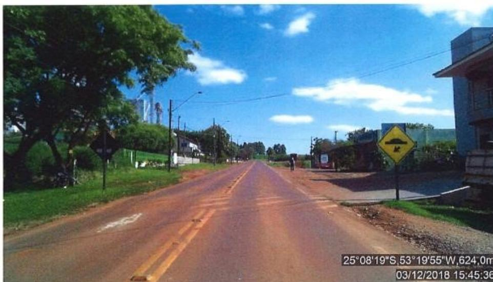
**Figura 57:**Sinalização horizontal desgastada (pintura de lombada e linha de bordo): PR-180, sentido crescente, km 355+860.
