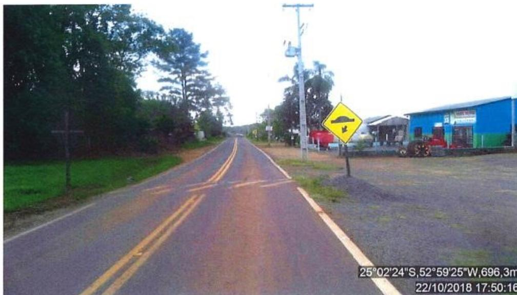
**Figura 44: Sinalização horizontal desgastada (pintura de lombada): PR-474, sentido crescente, km 7+030.**
