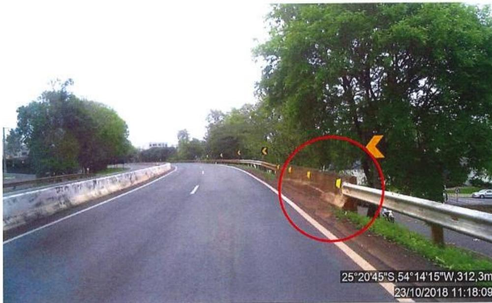
Figura 14: Transição inadequada entre defesa e elemento rígido: BR-277, Sentido crescente, km 688+270.
